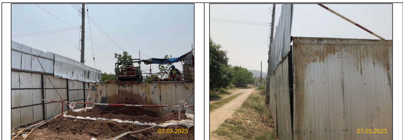
รูปที่ 2-10 ติดตั้งกำแพงกันเสียงบริเวณบ่อส่งจากการก่อสร้างด้วยวิธีการเจาะลอด (HDD) เมื่อพบว่าชุมชนหรือบ้านเรือนอยู่ในจากแนวท่อ
