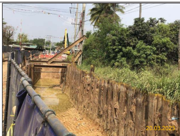
รูปที่ 2-12 การติดตั้ง Sheet Pile หรือ Trench Block ในพื้นที่ที่มีความเสี่ยงด้านดินถล่ม
