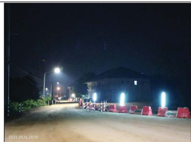
รูปที่ 2-25 การติดตั้งแสงสว่างและไฟกระพริบเตือนในเวลากลางคืน
