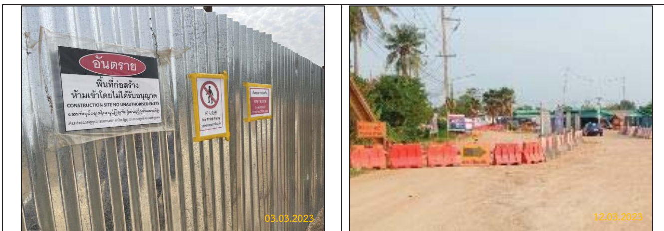
ฉ) การกั้นแบ่งเขตพื้นที่ การติดสัญลักษณ์ และป้ายเตือน
