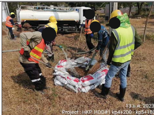
ข) การจัดเก็บโคลนโซเดียมเบนโทไนท์ที่ทะลักขึ้นในบริเวณพื้นที่ใกล้เคียง
