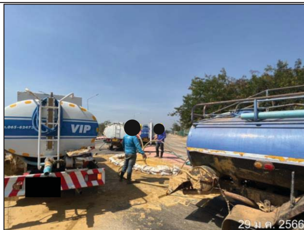
ข) การจัดเก็บโคลนโซเดียมเบนโทไนท์ที่ทะลักขึ้นในบริเวณพื้นที่ใกล้เคียง
