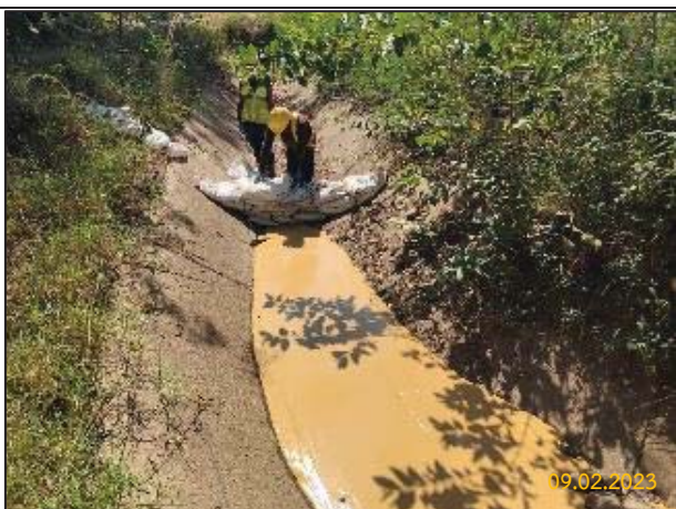
ข) การจัดเก็บโคลนโซเดียมเบนโทไนท์กรณีรั่วไหลลงแหล่งน้ำที่มีลักษณะน้ำตื้นและการปรับสภาพแหล่งน้ำ
