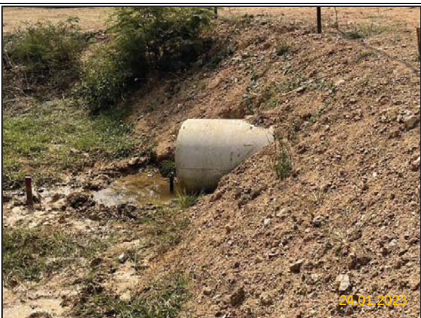
ค) การทำทางระบายน้ำชั่วคราวและถาวรด้วยการวางท่อลอดถนนทางเข้า-ออกสถานีควบคุมก๊าซ
