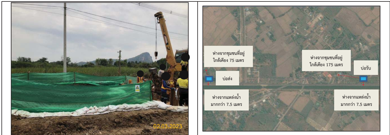
รูปที่ 2-8 การวางตำแหน่งของบ่อรับ-บ่อส่ง หลีกเลี่ยงบริเวณที่เป็นที่ตั้งของบ้านเรือนประชาชน และพื้นที่อ่อนไหว และมีระยะห่างจากแหล่งน้ำที่ทำการเจาะลอด
