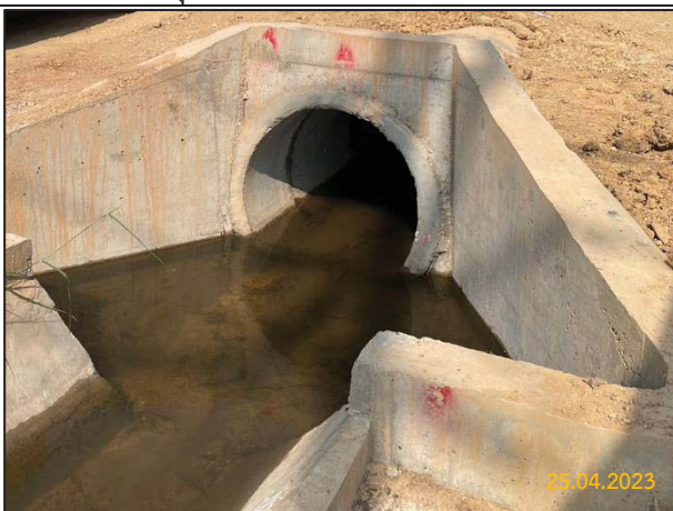
ค) การทำทางระบายน้ำชั่วคราวและถาวรด้วยการวางท่อลอดถนนทางเข้า-ออกสถานีควบคุมก๊าซ
