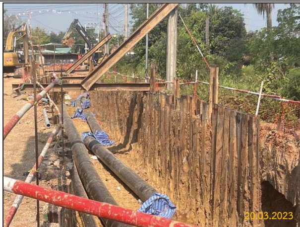
การติดตั้ง Sheet Pile
