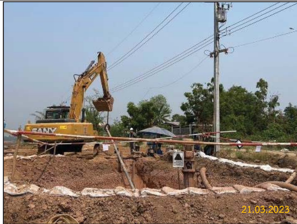
ก) จัดวางถุงทรายกันโดยรอบบ่อรับและบ่อส่ง
