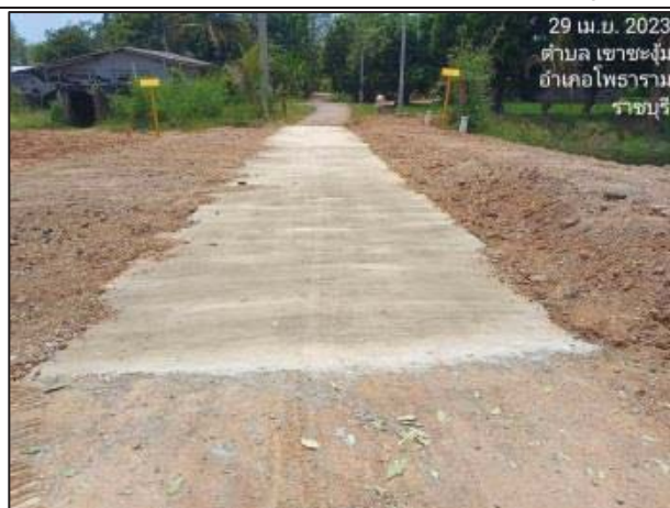
ช) การซ่อมแซมสภาพผิวจราจรที่ได้รับความเสียหายจากกิจกรรมก่อสร้าง
