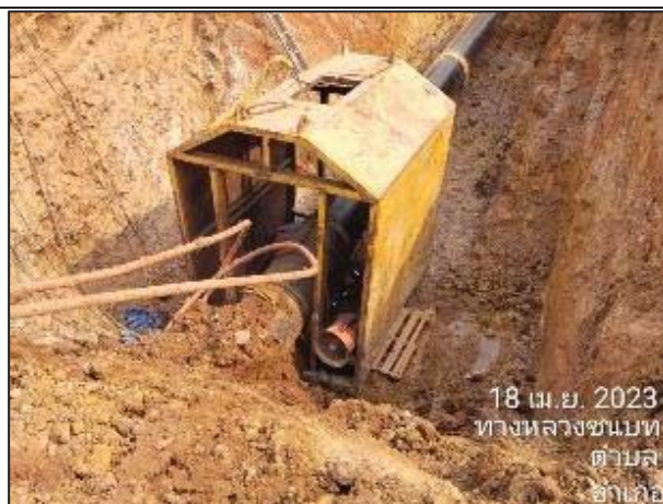
รูปที่ 2-12 การติดตั้ง Sheet Pile หรือ Trench Block ในพื้นที่ที่มีความเสี่ยงด้านดินถล่ม
