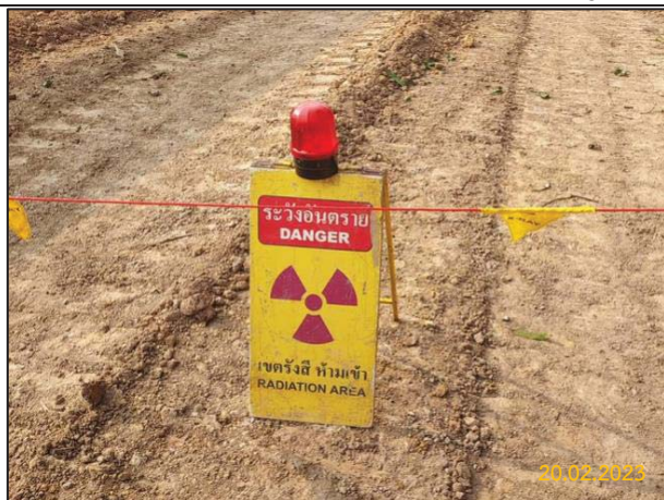
การกั้นเขตและการติดตั้งป้ายรังสีในบริเวณที่ดำเนินการตรวจสอบรอยเชื่อมด้วยรังสี
