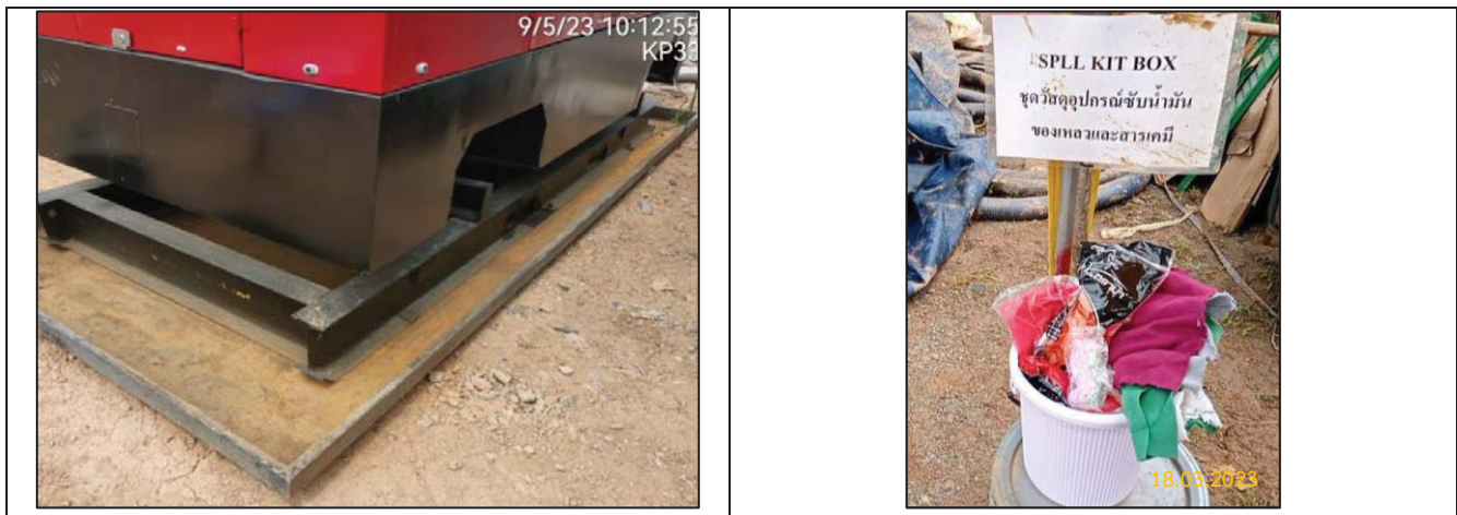
รูปที่ 2-21 การจัดเตรียมถาดเก็บรองรับน้ำมัน และวัสดุดูดซับ
