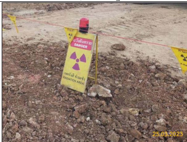
การกั้นเขตและการติดตั้งป้ายรังสีในบริเวณที่ดำเนินการตรวจสอบรอยเชื่อมด้วยรังสี
