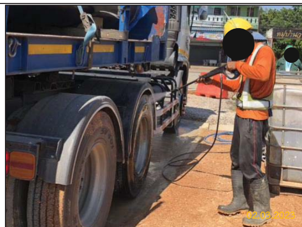
รูปที่ 2-7 การล้างทำความสะอาดเศษดิน เศษโคลน หรือทรายที่ติดล้อรถก่อนนำรถออกจากพื้นที่โครงการ
