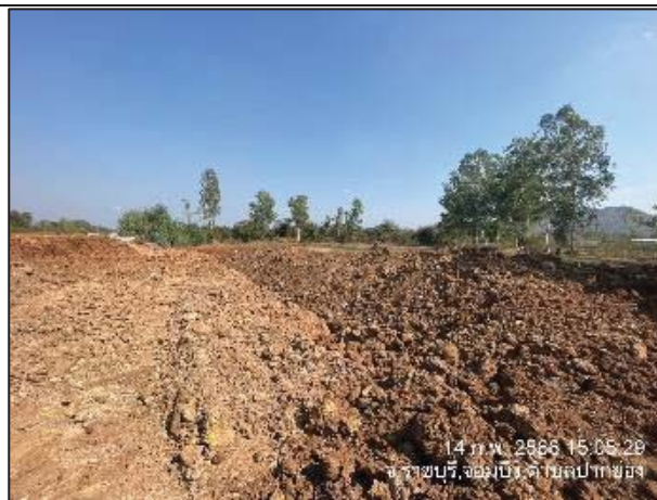
รูปที่ 2-11 การทำพูนดิน (Crown) บริเวณพื้นที่หลังท่อ
