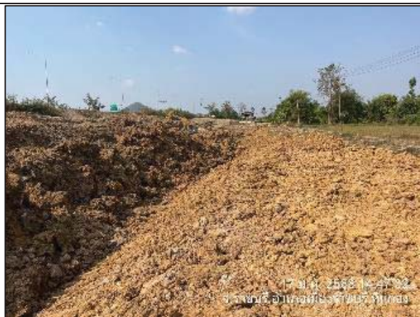
รูปที่ 2-11 การทำพูนดิน (Crown) บริเวณพื้นที่หลังท่อ
