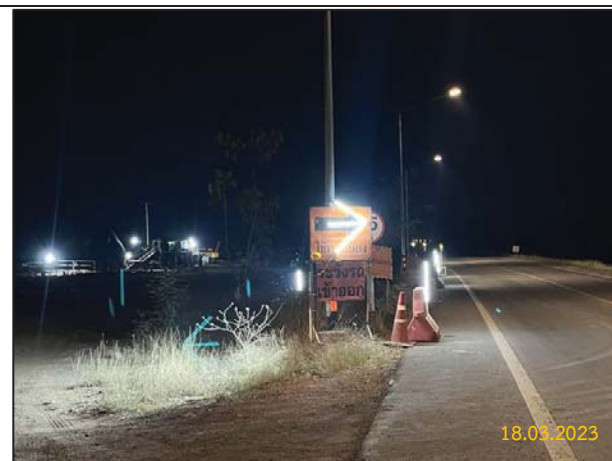
รูปที่ 2-25 การติดตั้งแสงสว่างและไฟกระพริบเตือนในเวลากลางคืน
