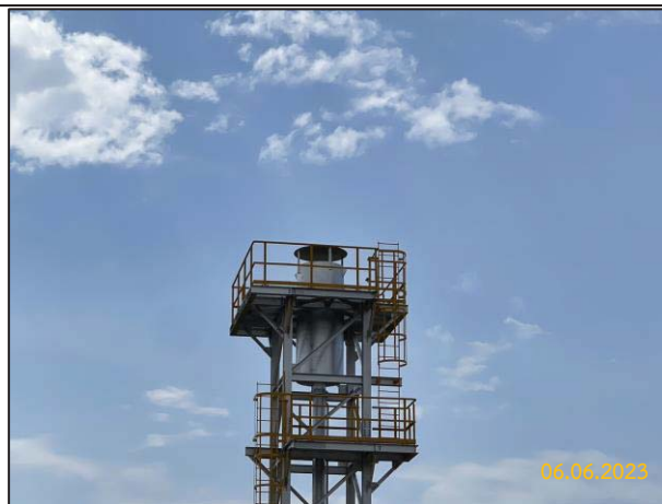
ก) การติดตั้งอุปกรณ์ลดเสียง (Silencer) ที่ปล่องระบายก๊าซ (Vent Stack)
